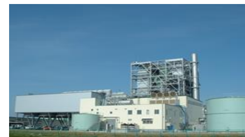
【 苫小牧発電所 】
