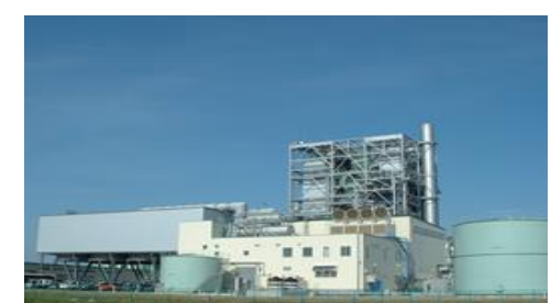
【 苫小牧発電所 】
