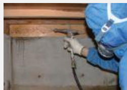
白蟻防除施工
