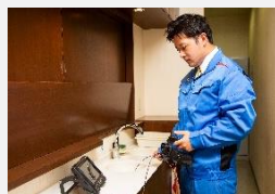
ビデオスコープによる水道管検査
