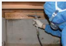
白蟻防除施工
