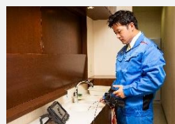
ビデオスコープによる水道管検査
