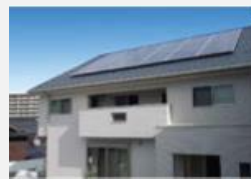
住宅用太陽光発電システム
