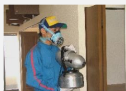
害虫防除施工
