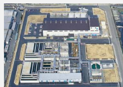
廃液処理工場
