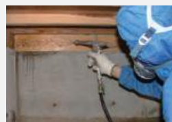
白蟻防除施工
