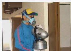
害虫防除施工
