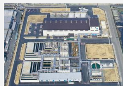
廃液処理工場
