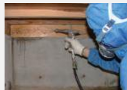
白蟻防除施工
