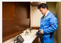
ビデオスコープによる水道管検査
