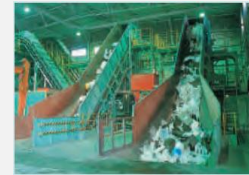
プラスチック資源開発工場
