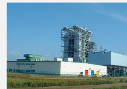
苫小牧発電所
