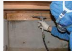
白蟻防除施工
