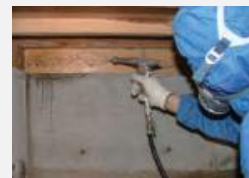
白蟻防除施工
