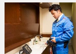
ビデオスコープによる水道管検査
