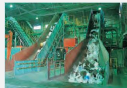
プラスチック資源開発工場
