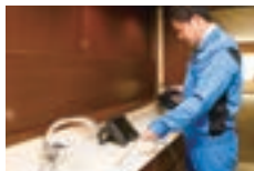
内視鏡による給排水管内部の検査
