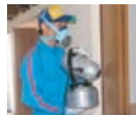
害虫防除施工
