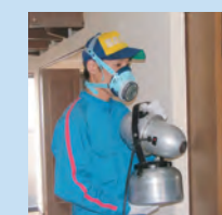
害虫防除施工
