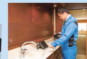
内視鏡による給排水管内部の検査
