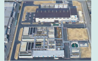
ひびき工場(廃液処理工場)
