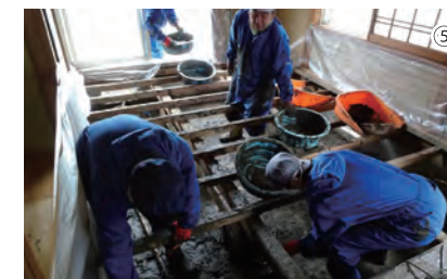
福岡県東峰村において、浸水住宅の床下泥土除去・防疫消毒等、復旧支援を実施(2017年)。
