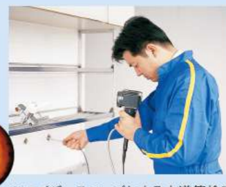
ファイバースコープによる水道管検査
