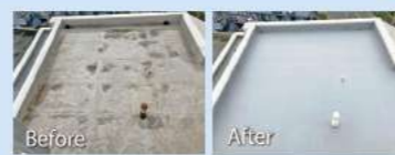
屋上防水処理
