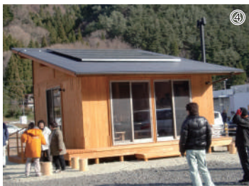
岩手県盛岡市被災地支援施設建設プロジェクトに協賛し、大槌町の集会所に太陽光発電を提供(2011年)。
