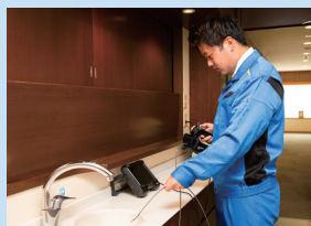
内視鏡による給排水管内部の検査
