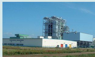
サニックスエナジー 苫小牧発電所
