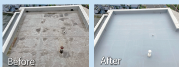
屋上防水処理
