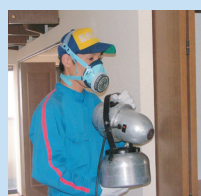
害虫防除施工
