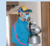
害虫防除施工
