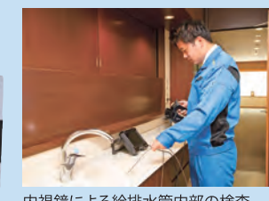
内視鏡による給排水管内部の検査
