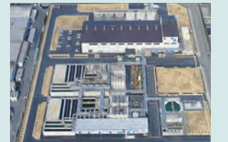
ひびき工場(廃液処理工場)
