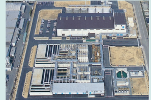
ひびき工場(廃液処理工場)
