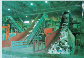
プラスチック資源開発工場
