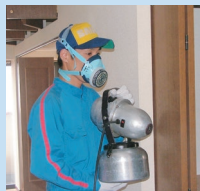
害虫防除施工
