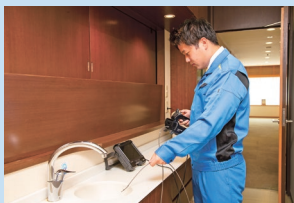
内視鏡による給排水管内部の検査
