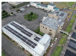
福岡市多々良浄水場
