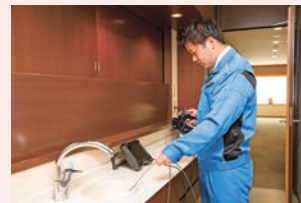
内視鏡による給排水管内部の検査
