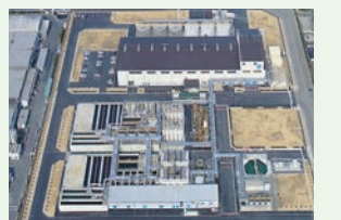
ひびき工場(廃液処理工場)
