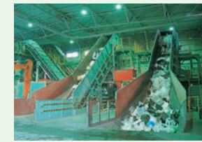
プラスチック資源開発工場
