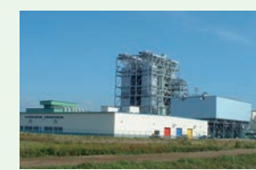
サニックスエナジー 苫小牧発電所
