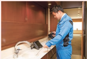
内視鏡による給排水管内部の検査
