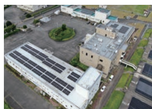
福岡市多々良浄水場
