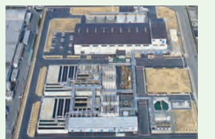
ひびき工場(廃液処理工場)
