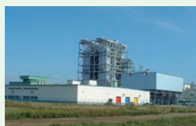
サニックスエナジー 苫小牧発電所
