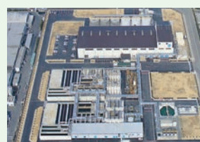
ひびき工場（廃液処理工場）
