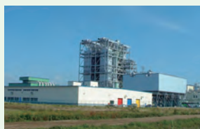
サニックスエナジー 苫小牧発電所
