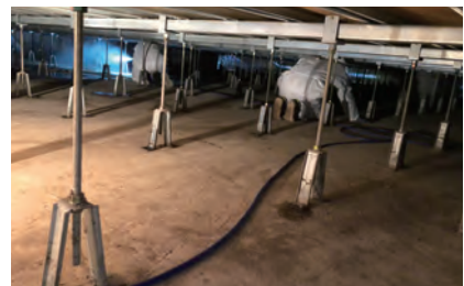
令和2年7月豪雨の災害を受けた小学校（大分県九重町）の床下殺菌消毒を実施（2021年）。
