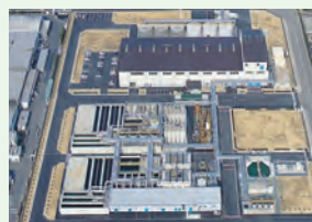
ひびき工場（廃液処理工場）
