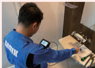
内視鏡による給排水管内部の検査
