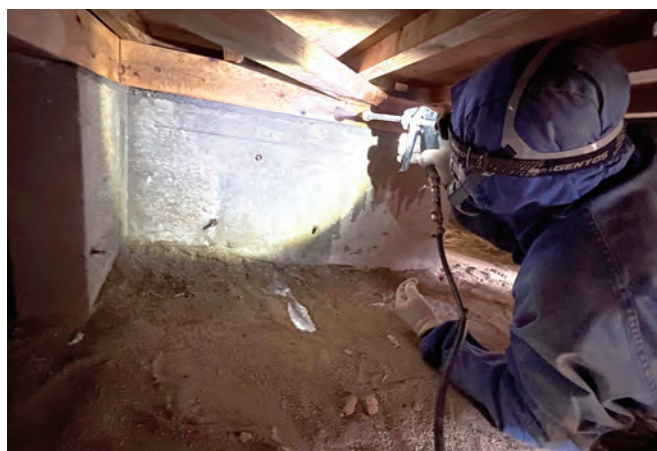
シロアリ防除施工
