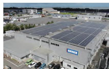
新潟工場の太陽光発電(設備容量231kW)
