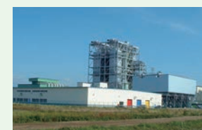
サニックスエナジー 苫小牧発電所
