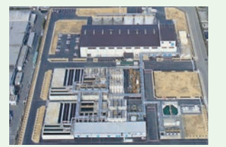
ひびき工場（廃液処理工場）
