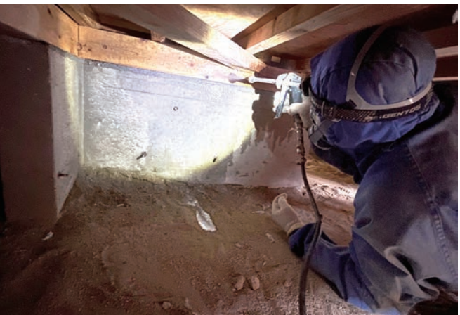
シロアリ防除施工
